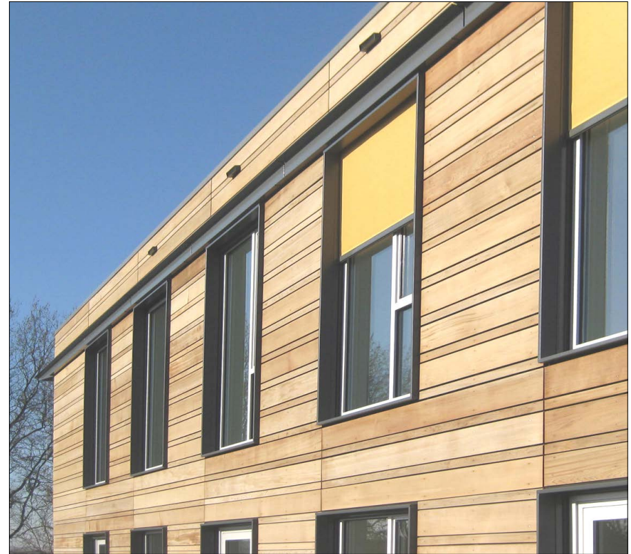
Raamopeningen op de bovenste verdiepingen
