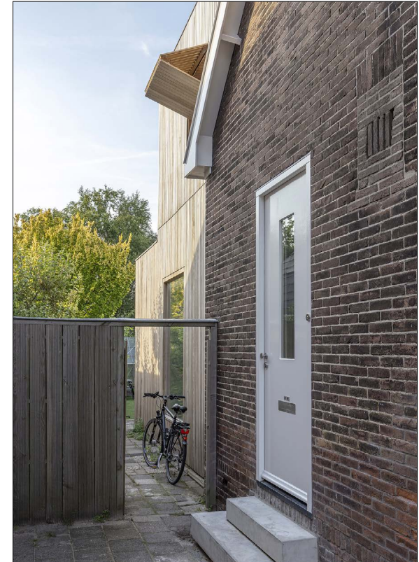
Nieuwe voordeur zijgevel
