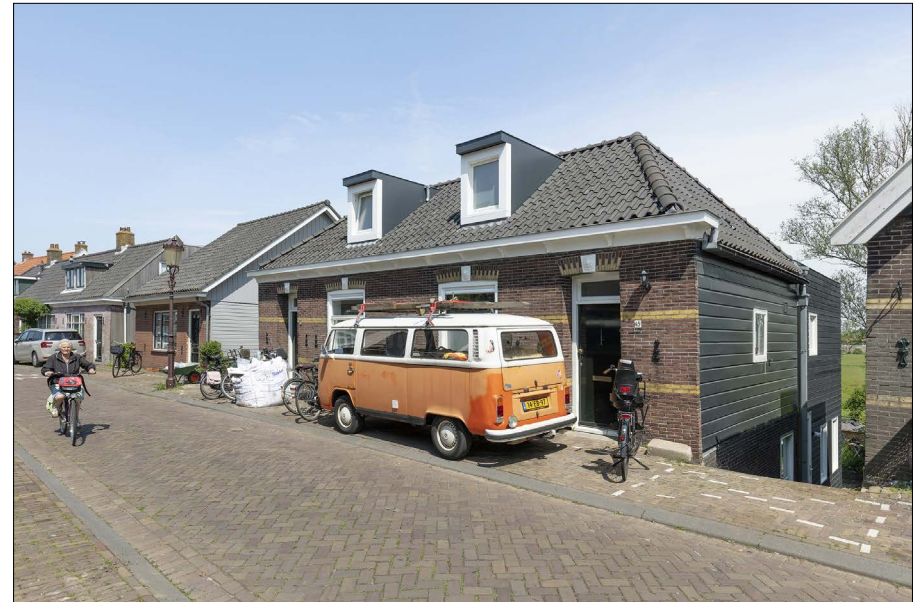
Voorgevel met de nieuwe dakkapellen
