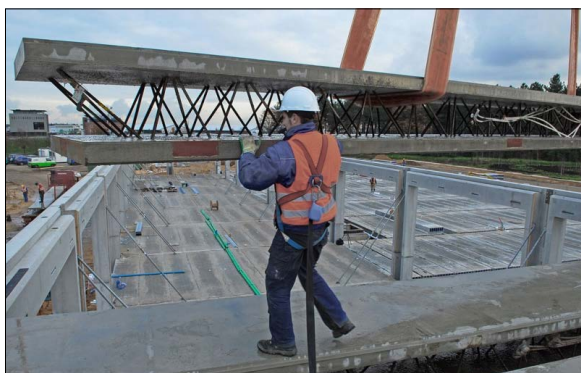
Montage d.m.v. boutverbindingen
