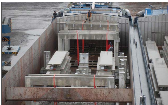
Aanvoer van prefab betonelementen per schip
