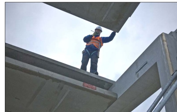
Opleggen vloerelementen
